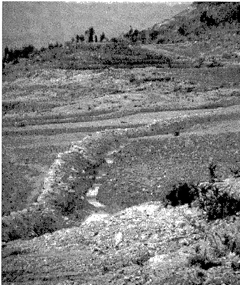
Figure 8. On utilise de plus en plus du sol riche en pierres comme remblai pour les murets. Ceci évite le ramassage excessif de pierres du champ. Les tranchées d'excavation servent à faciliter l'infiltration. (Adi Kolakol, début juillet 1999).
